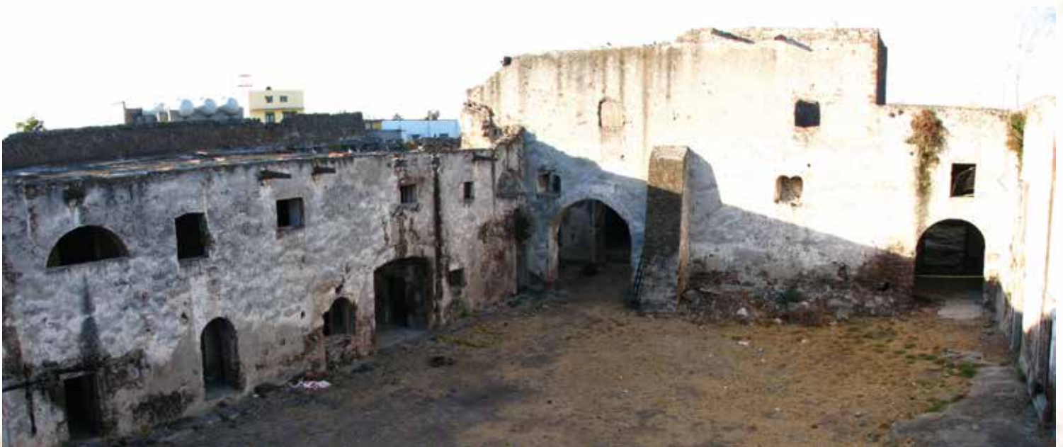
Interior del Portal del Diezmo en ruinas. Ca. 2009
