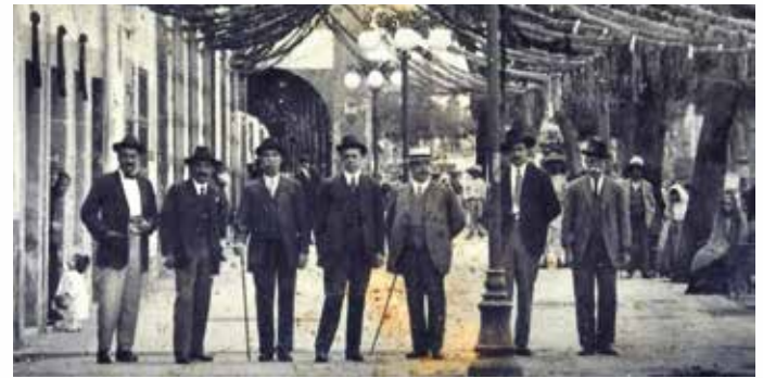
Don Ernesto Perusquía (al centro de la fila) dueño del Portal del Diezmo, justo en la acera de la antigua Calle Real y detrás de ellos el edificio.
