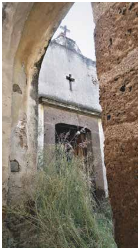
Vista del arco de acceso al atrio y puerta a la capilla otomí en San Isidro
